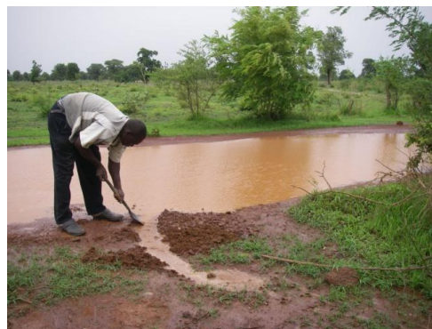
道路の排水作業(2018.7 コビリ道)
