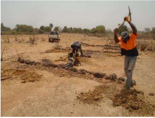
石組みを補強する
