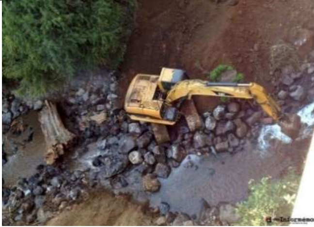
テポストランの高速道路拡張工事現場
