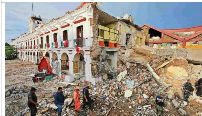
地震で崩壊したフチタン市庁舎
