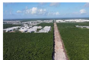
第5区プラヤ・デル・カルメン郊外の植生伐採
