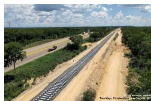
第3区ユカタン州マシュカヌのレール敷設の工事現場
