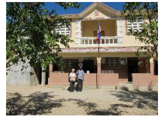
支援で建設した学校
