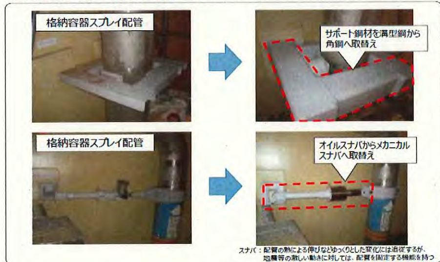
【図15 格納容器スプレイ配管の耐震補強工事例（疎乙第25号証抜粋）】
