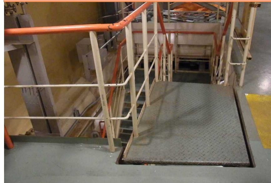
外周路通路部の階段の写真
