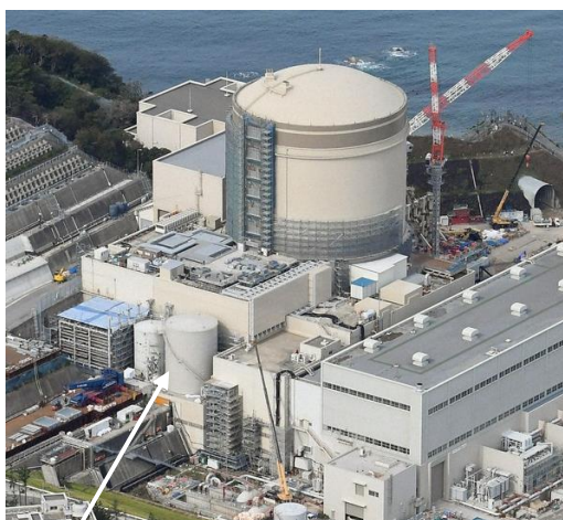
燃料取替用水タンク 毎日新聞2020.7.8より (2019.11.3撮影)
