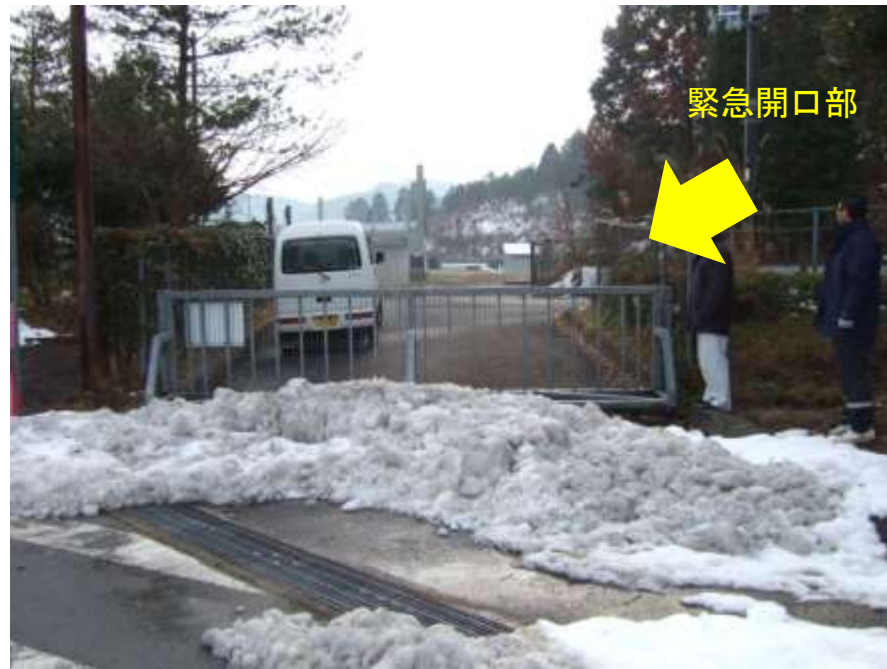
① PA内から緊急開口部を撮影
