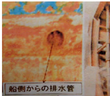
船側からの排水管
