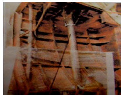
艙の上甲板からの縦排水管
