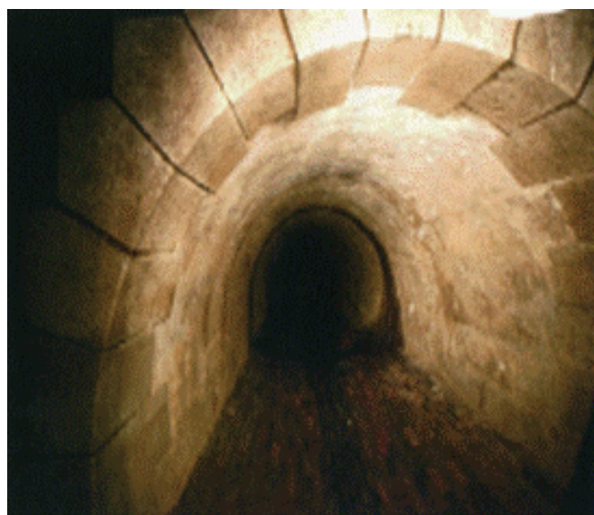
ポンプ場への導水渠
