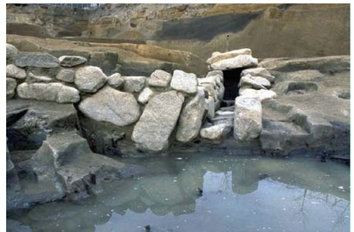
NHK地下の排水設備（大阪市文化財協会）
