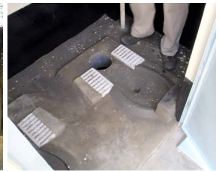
完成したトイレの外観と内部、し尿分離式になっている
