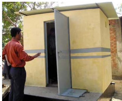
完成したトイレの外観と内部、し尿分離式になっている
