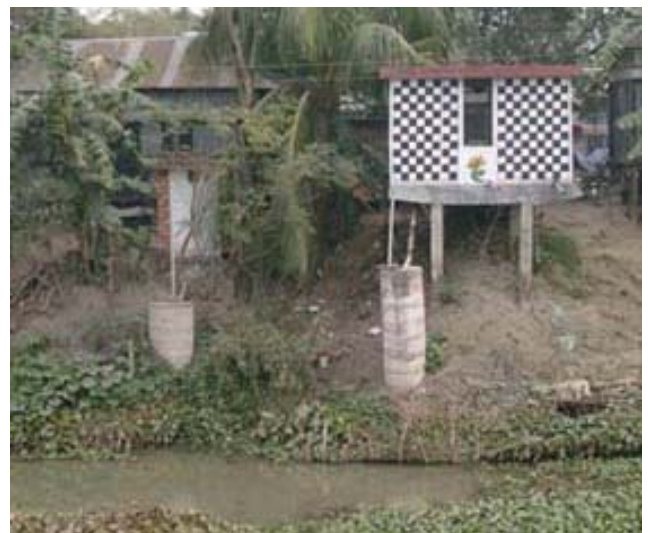
盛土された宅地の斜面に造られたトイレのピット
