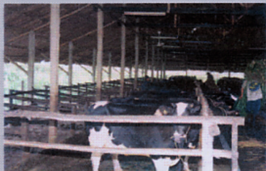
Một trại nuôi bò sữa ở Xã An Nhơn Tây, huyện Củ chi xây dựng đúng tiêu chuẩn được các chuyên gia nước ngoài đánh giá cao.
