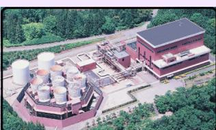
柳津西山(やないづにしま)地熱発電所は、単一ユニットで日本最大の出力65,000kWの地熱発電所で、最大で約10万世帯の一般家庭が消費する電力を賄うことができる。1995年5月運転開始。東北で7番目。全国では15番目だそうです。発電所は無人で運転し続けるが必要に応じて秋田火力発電所から遠隔操作されているとのこと。wikipediaによると、「発電の際に地中から噴出する硫化水素等を回収するプラントをもち、回収物を肥料や火薬の原料として内外の企業に向け出荷している。」のだそうです。
