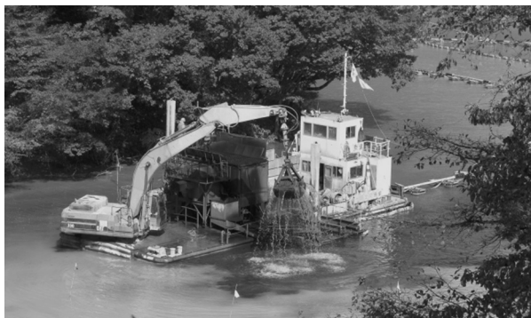
石灰中和物のヘド口の浚渫作業船 (品木ダム)
