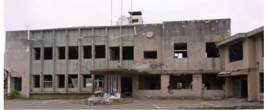
↑津波によって破壊された役場
