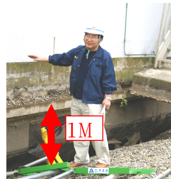
原発敷地内 タンク保護壁の脇 地盤沈下のあと。
