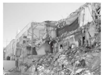
爆撃されたパレスチナ自治政府の建物 (故アラファト議長のオフィス)
