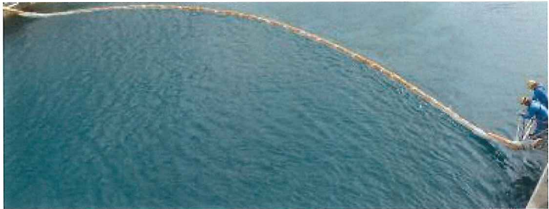
【図表 1 4 適合性確認検査におけるシルトフェンス設置の様子】
