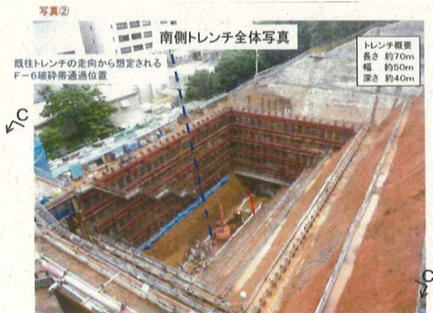
【図3 南側トレンチ全体写真（丙第61号証の2・46ページ）】
