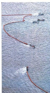
作業 フロートの設置作業をする并機時作業の作業種一年後 2級2号（本社チャーターヘリからの取組工法班員）
