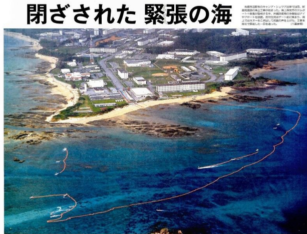
「整備」 キャンプ・ニュー・シユワップの防波堤の設置作業(2014年8月15日撮影)
