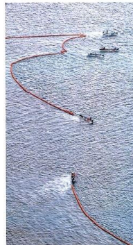
「作業」 170メートルの防波堤を築くための防波堤の設置作業(2014年8月15日撮影)
