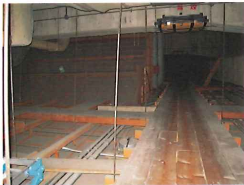
第2ホール点検歩廊
