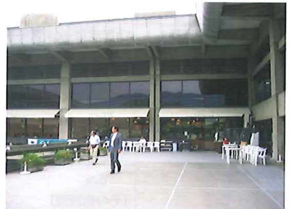
京都会館2階バルコニー
