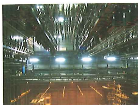
事例写真：フライタワー内部
