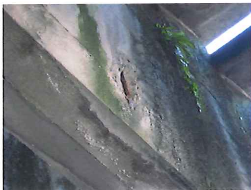
中庭屋外階段（背面）
