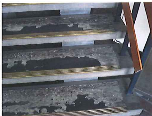
会議棟階段の床材
