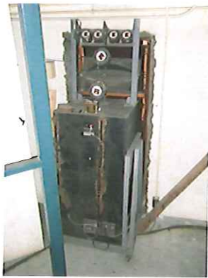
第2ホール音響用スピーカー（背面）
