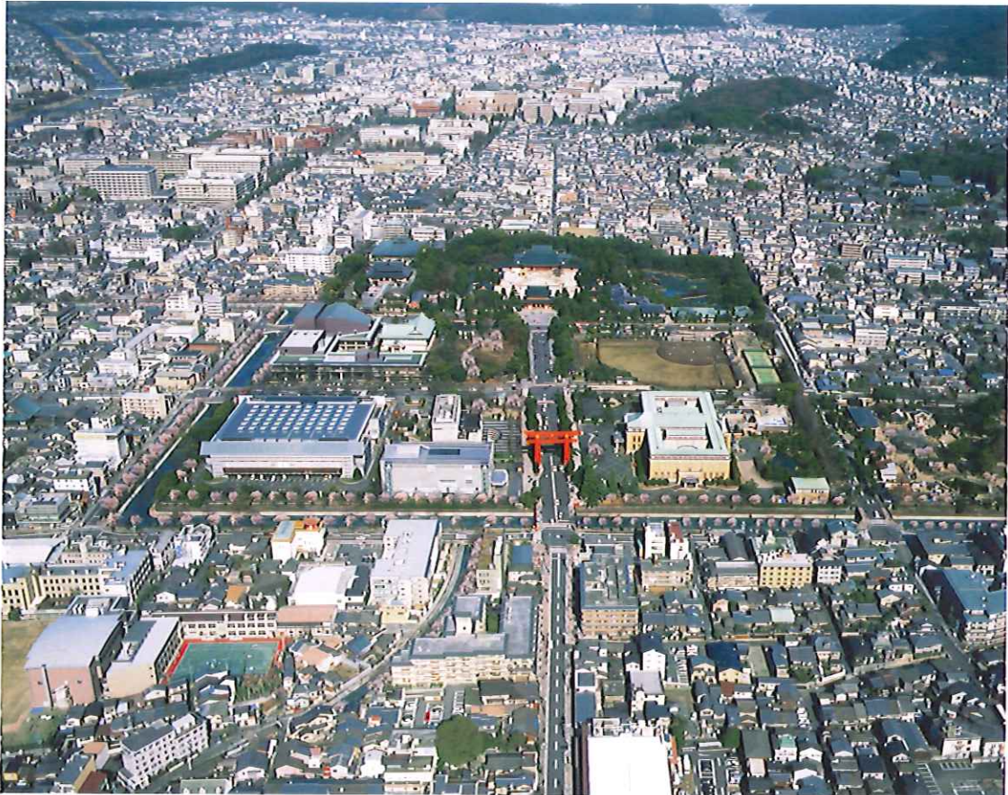
岡崎地域・鳥瞰写真モンタージュ（南より）
