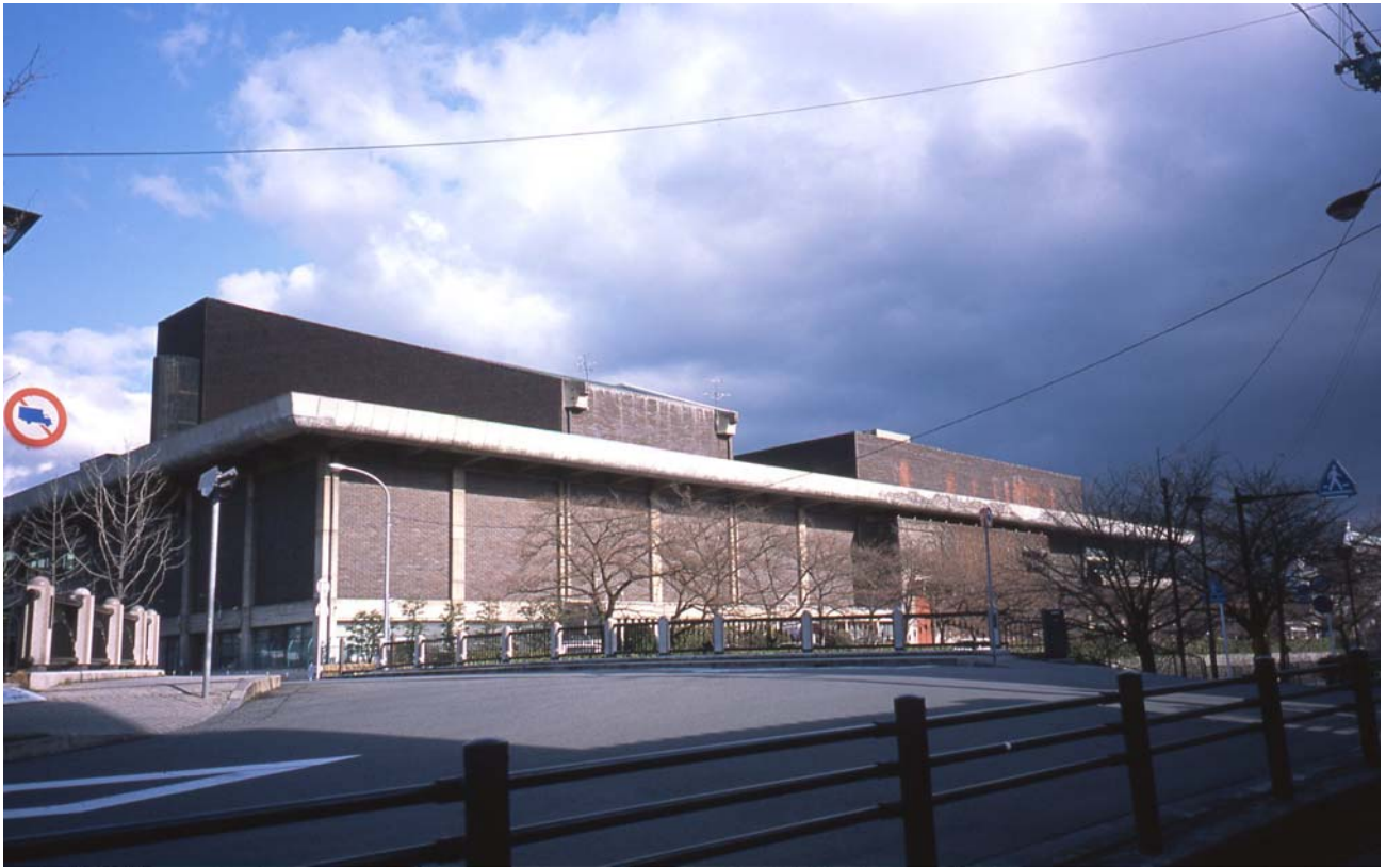
「京都会館」の琵琶湖疏水に面した西側の現況
