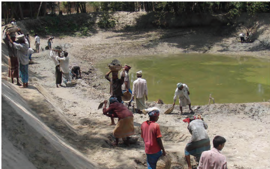
飲み水の水源とするため池の掘削
