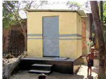
エコサン・トイレ外観
