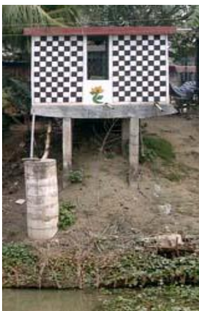
写真-6(1) 宅地斜面に造られた Pit Latrine
