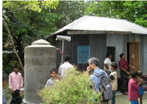
写真-5(2) 雨水タンクの導入事例
