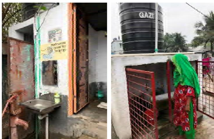
(左) 改修されたトイレ、トイレの上のタンク、トイレ内の蛇口、手洗い場が見える／(右) 既設の井戸に手を加えて水汲み場に
