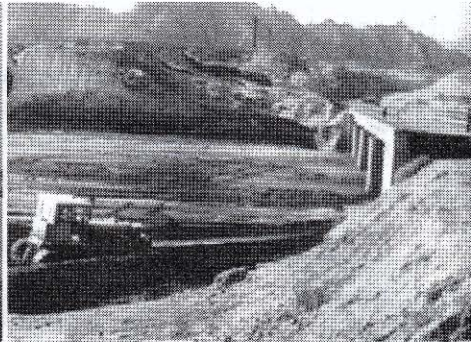
土石流で流された橋
