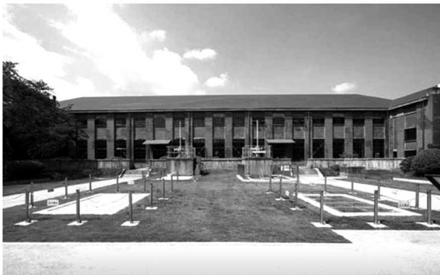
写真－３ 東京都三河島污水処分場唧筒(ポンプ)場施設(東京都荒川区荒川８丁目 三河島水再生センター内)
