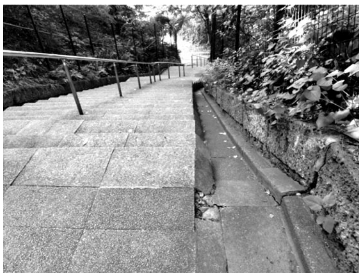
写真－６ ブラフ溝（横浜市中区山手町 フェリス中高等部脇階段道）
