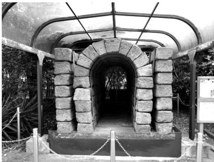
写真－５ 関内地区石造馬蹄形管渠（横浜市中区山下町 横浜市中部水再生センター）
