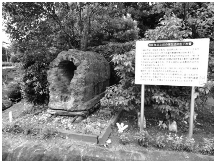
写真－4 横浜外国人居留地卵形型煉瓦管（横浜市鶴見区末広町1丁目 横浜市北部第二水再生センター）
