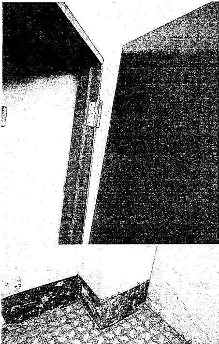
①はずれた収納のドア②さびや傷みが目立つ浴室。いずれもAETのメンバーが撮影した。昨年5月、大阪府高槻市春日町
