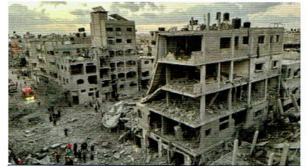
イスラエル軍の攻撃で廃墟となった住宅ビルが並ぶガザ (写真:ロイター/アフロ)
