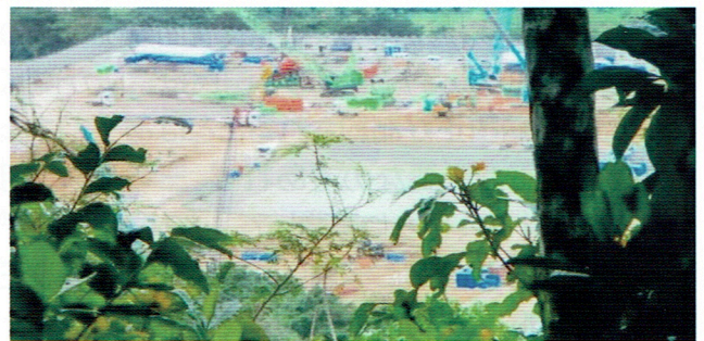
八重山農林高校演習林から見える工事現場の一部
